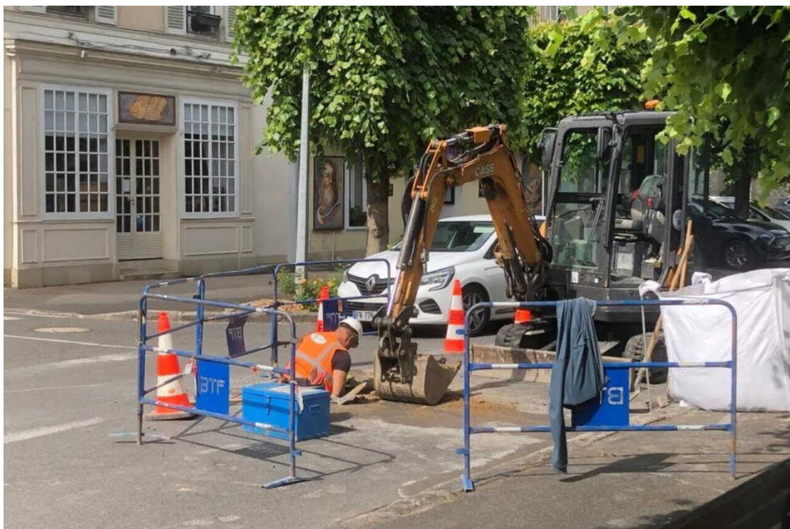
Les travaux dureront deux mois ©A.L./RSM77
